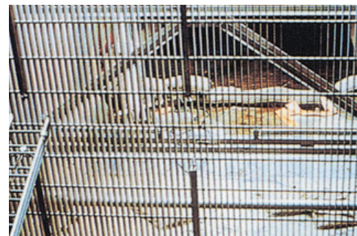
バースクリーンに対するアラノードの取付状況
