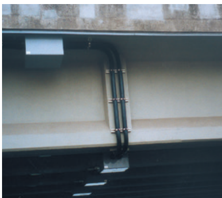
モルタル被覆後
