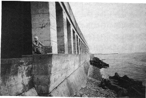
写真-2 施工前の現場
