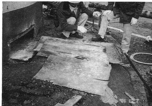
写真-4 底板とジンシートの切出し
