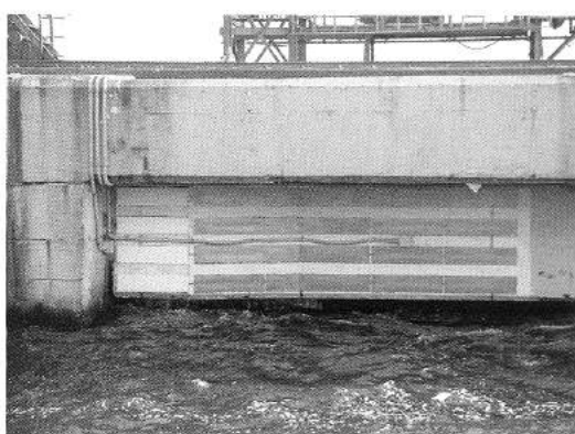
写真 5 電気防食工法施工後の栈橋外観
