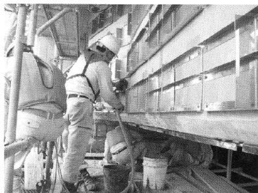
写真 4 モルタル注人状況
