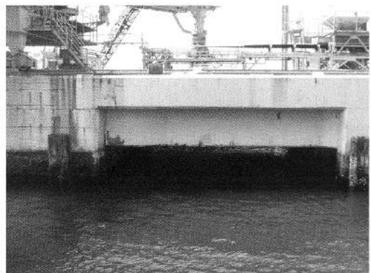
写真 1 電気防食工法施工前の棧橋外観
