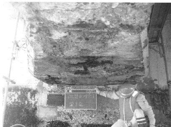
写真 2 劣化コンクリートはつり後の外観
