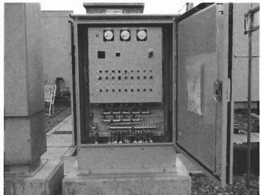
写真-5 直流電源装置設置状況
