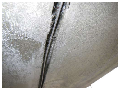
写真2 一次陽極（白金チタン線）取付状況
