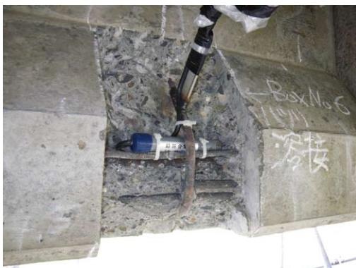
写真1 鉛照合電極（青色）および排流点金具取付状況
