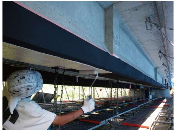
写真5 トップコート（白色）の 塗布状況
