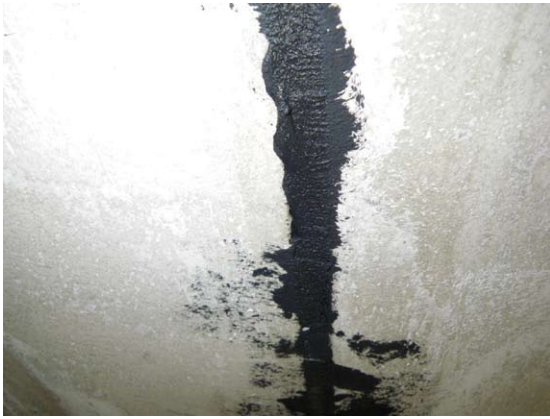
写真3 導電性パテ（黒色）を 溝内に充填
