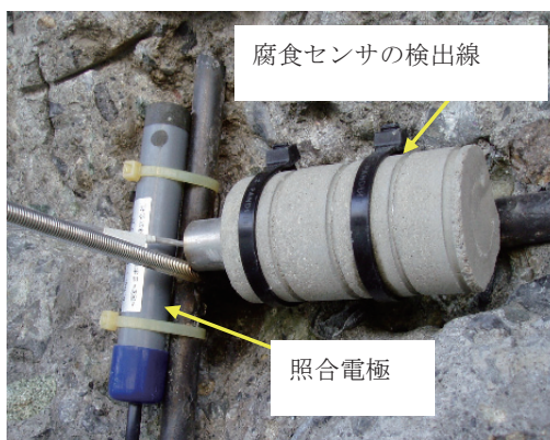
図6 腐食センサ設置状況
