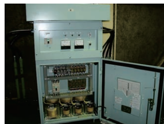
写真 10 直流電源装置設置
