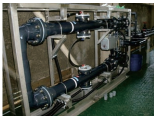
写真 11 電解槽ユニット設置
