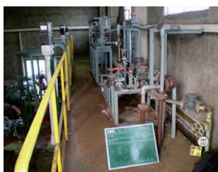
写真 8 既設装置撤去前
