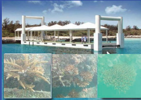
浮棧橋設置後4年が経過したサンゴ
