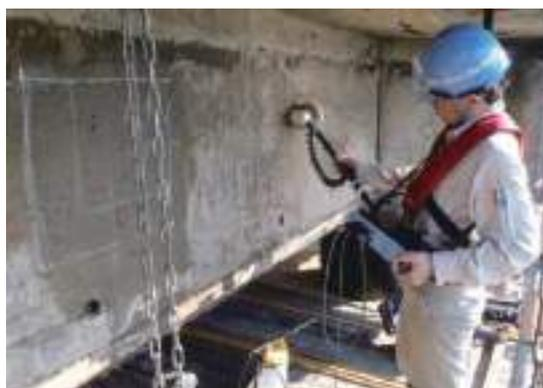
図-2 電位測定状況（回転式照合電極）
