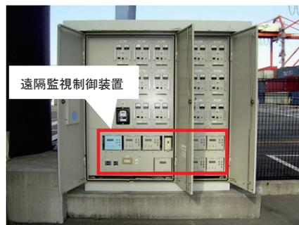
図 9 大規模棧橋で運用されている遠隔監視制御装置付き電源装置
